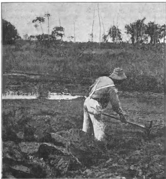
Выламываніе асфальтовыхъ глыбъ на поверхности Тринидадскаго „асфальтоваго озера“.
